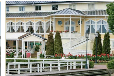
Naantalin Kaivohuone, Finland
